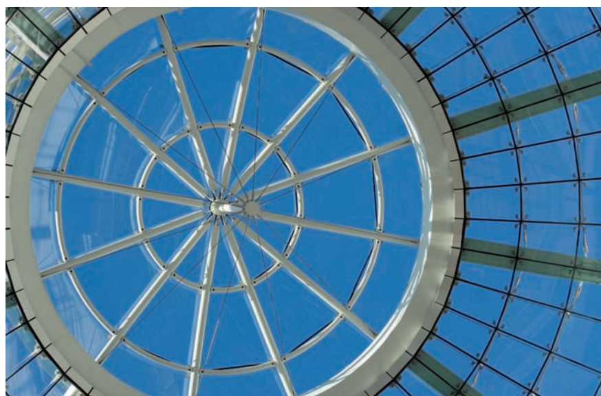
Kreisförmige Dachkuppel aus Aluminiumprofilen
